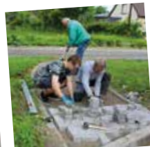
Maçonnerie rue des Mélèzes
