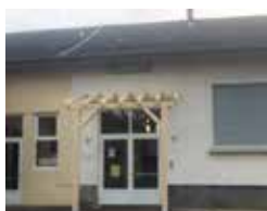
Toit Ecole La Sirène de l'Ill Didenheim
